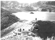
Fond de la baie, d'Alarai. Au premier plan, l'ancienne station météo.
